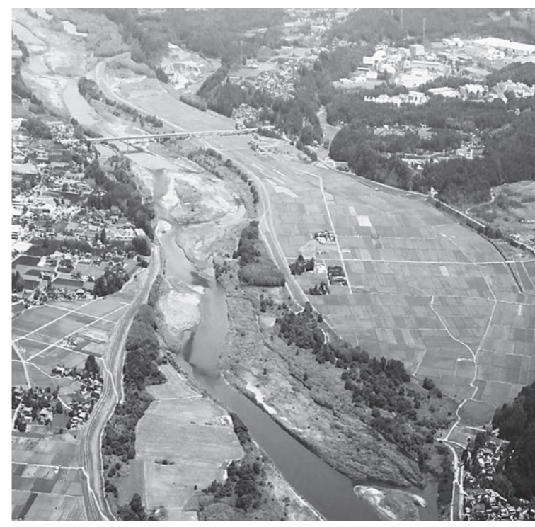
遊水・貯留機能の向上へ整備が進む
