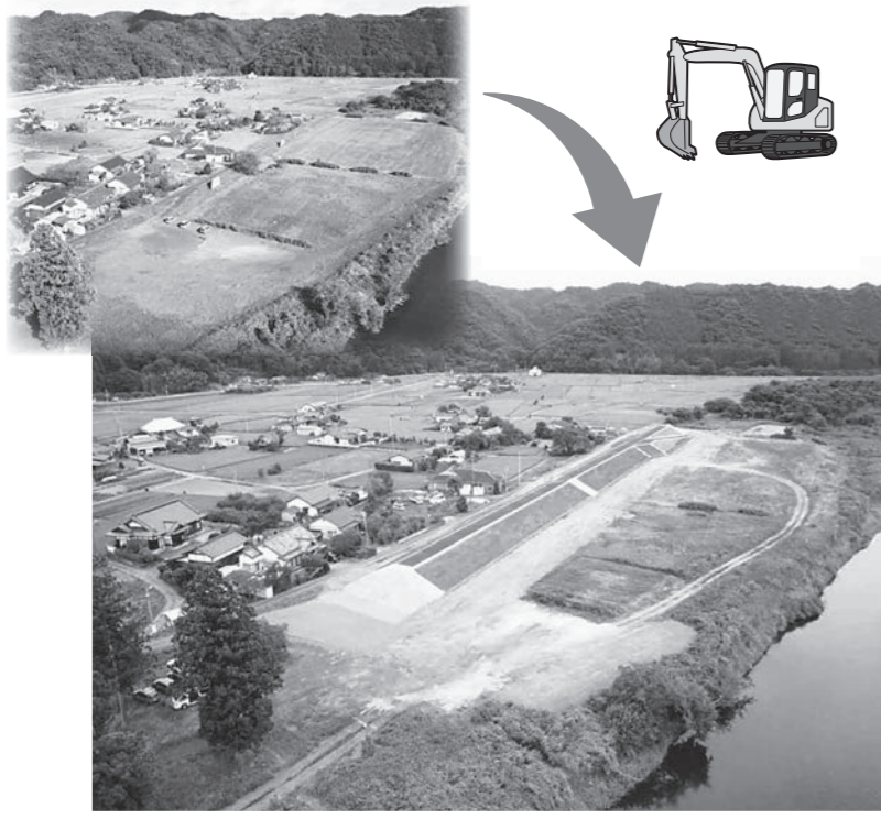
常陸大宮市西野内地区内では築堤盛土や護岸を設置
