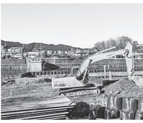
旧橋の左岸側が撤去済み
